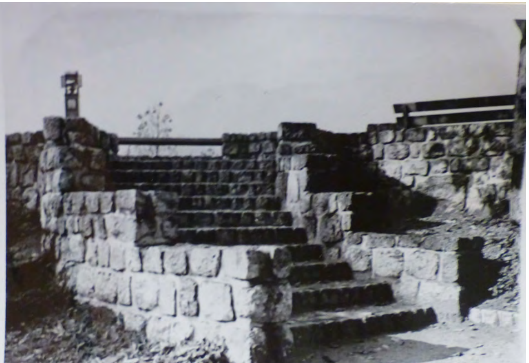
„Aussichtsgalerie“ mit Aufgang, Ohne Vorlage u. Genehmigung 1938 ausgeführt, Fotografie, vermutlich 1941. Innsbruck, BDA, LK Tirol, Fotoarchiv, K 1142.
