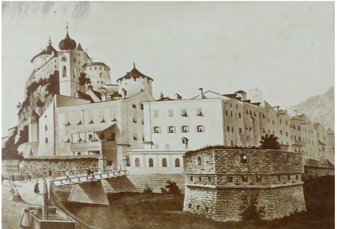
Ansicht von Norden, Fotografie nach einem Aquarell von Josef Czichna, um 1862. Wien, OESTA, KA, KPS KS G VI, 6149 (aus dem Nachlass Maretich).
