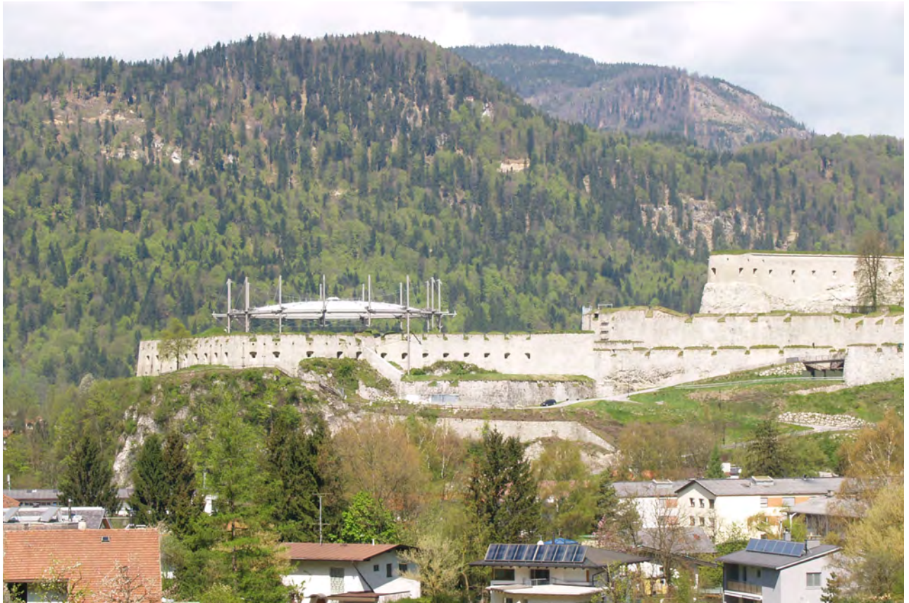
Aufnahme Richtung Westen, die ausgedehnte Josefsburg mit wandelbarem Membrandach.
