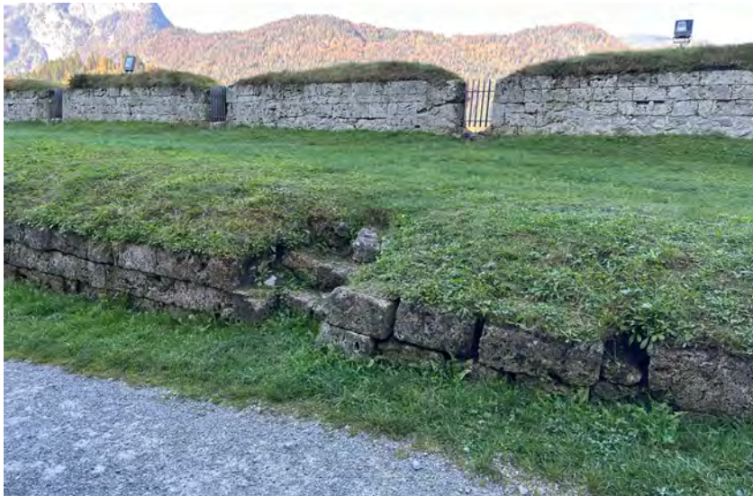
Krone der Stützmauer mit Grasabdeckung, Begleitmauer im Vordergrund.
