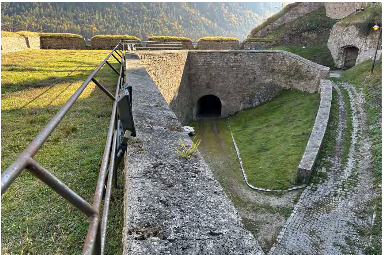
Aufnahme Richtung Südwesten mit Blick in den Hof und auf die kopfsteingepflasterte Rampe.
