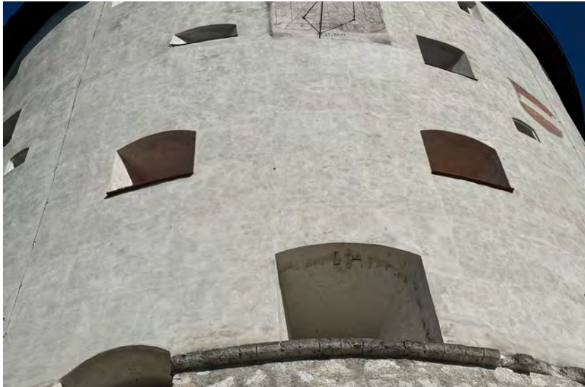
Südseite Kaiserturm in gutem Zustand.
