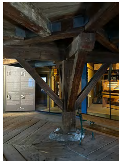
Tragkonstruktion Dachstuhl.
