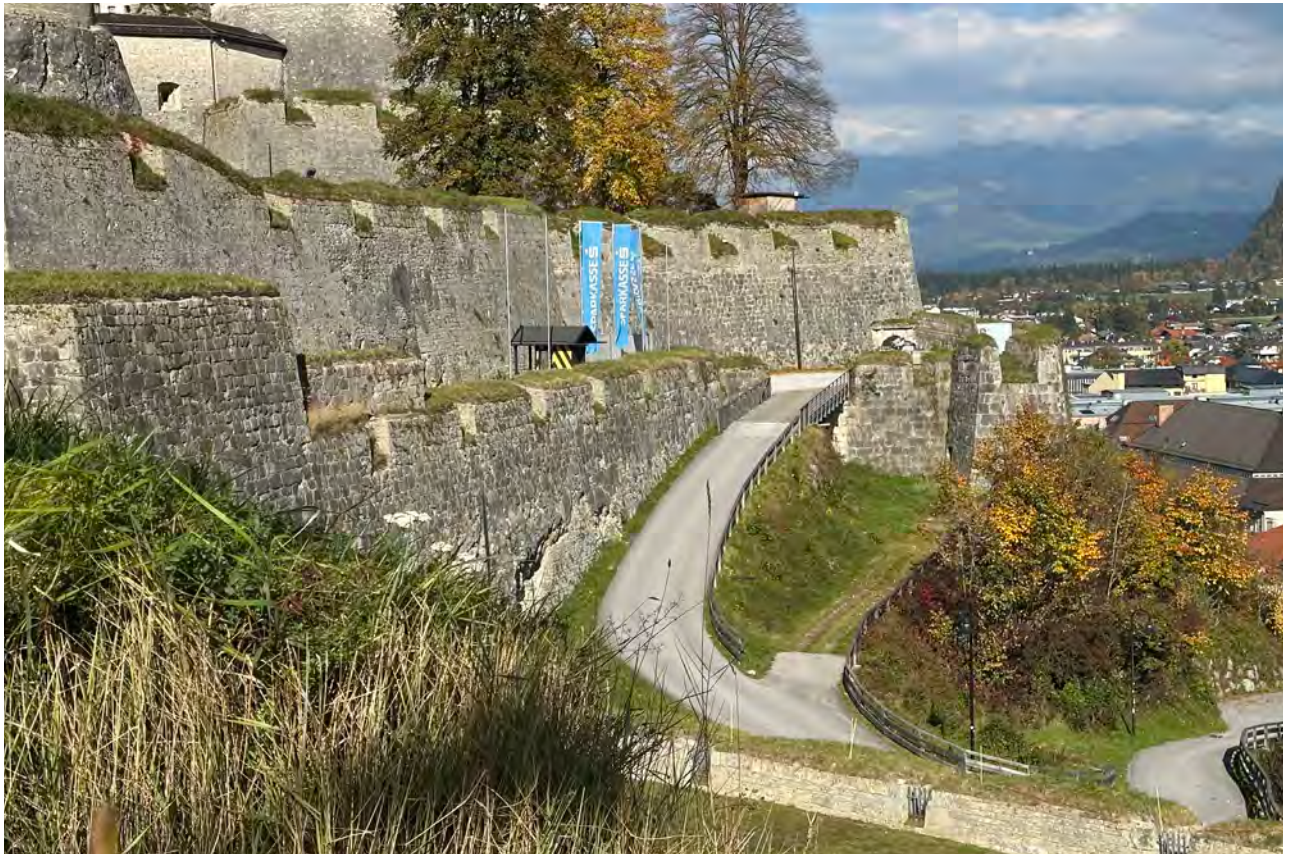
Aufnahme Richtung Nordosten mit Blick auf die Stützmauer des Eugen-Halbhornwerks links, dahinter die Anna-Batterie.
