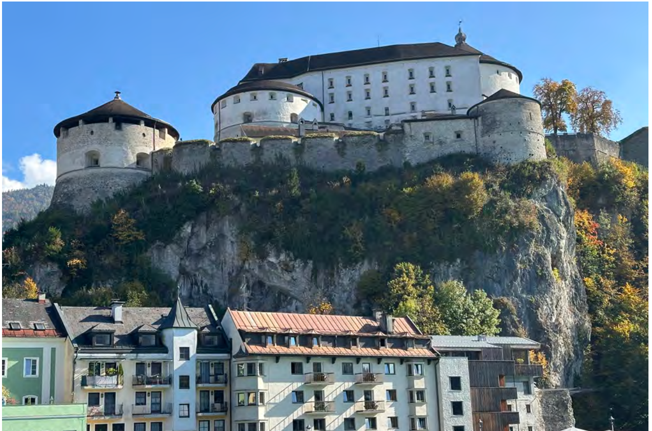
Aufnahme Richtung Osten mit Blick auf die Untere Schlosskaserne mit Gaudenzbatterie, Magazingebäude und Fuchsturm.
