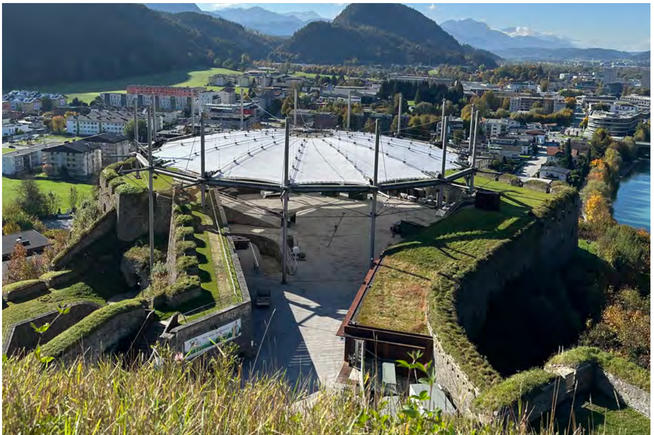
Aufnahme Richtung Südwesten mit Blick in den überdachten Hof und auf die Kasemattendächer.
