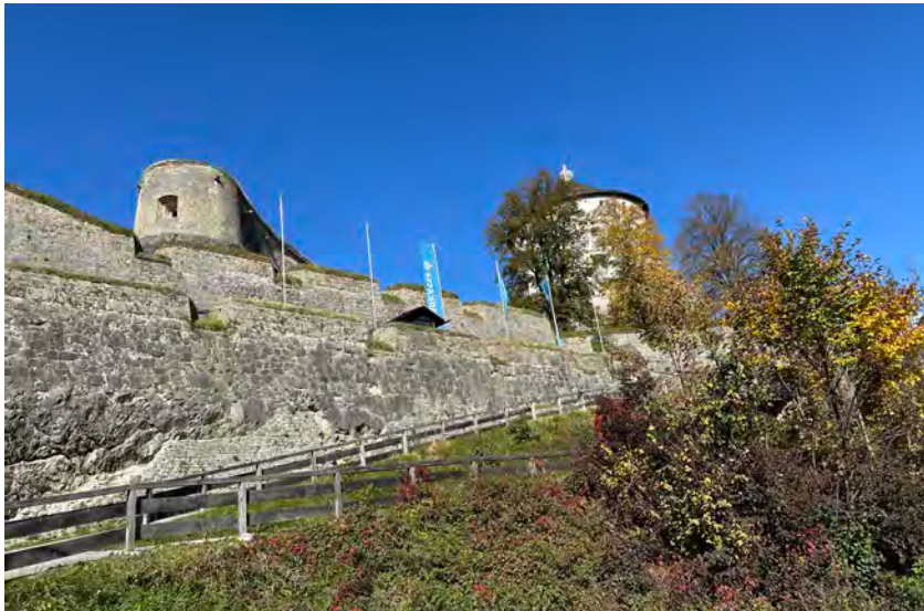
Stützmauer des Eugen-Halbhornwerkes.
