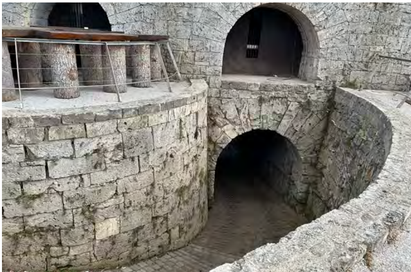
Rampe zum Francisci-Ravelin.
