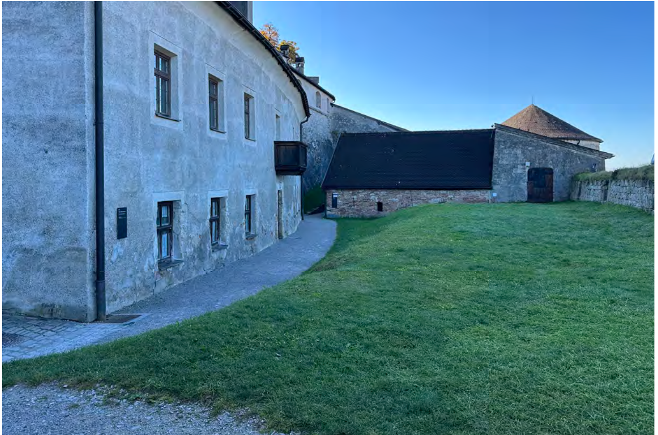
Aufnahme Richtung Südwesten mit Blick in die Gaudenzbatterie mit Tiefem Brunnen und Magazingebäude, links das Mannschaftsgebäude.
