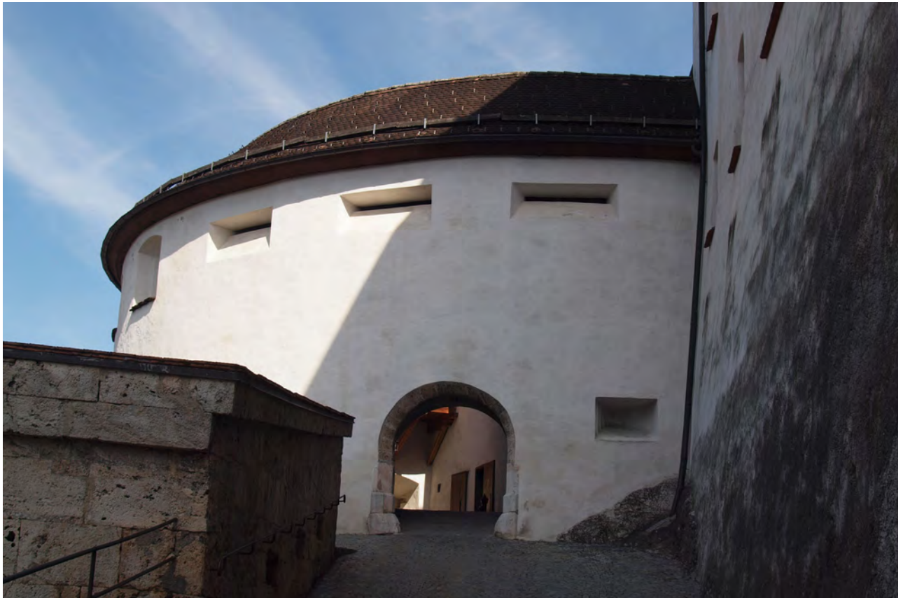
Aufnahme Richtung Nordosten mit Eingang zum Hofbereich.
