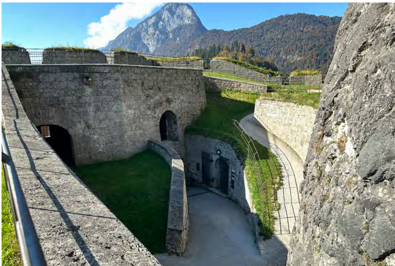
Aufnahme Richtung Westen mit Durchgang zur Josefsburg, Zugang zum Felsengang und den Öffnungen zu den Räumen im Torbau.
