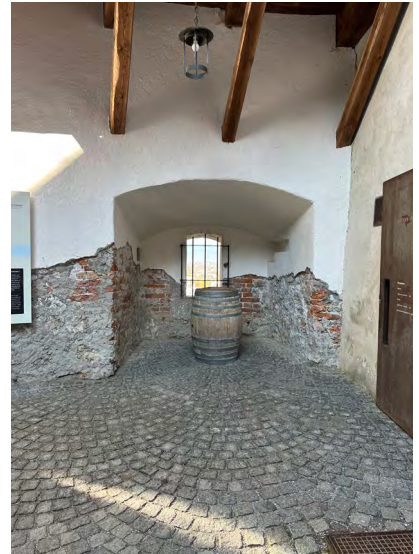
Putzeneruerung im Sockelbereich.
