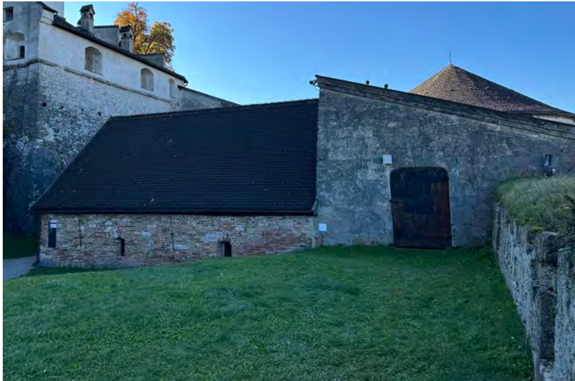
Tiefer Brunnen und Magazingebäude.
