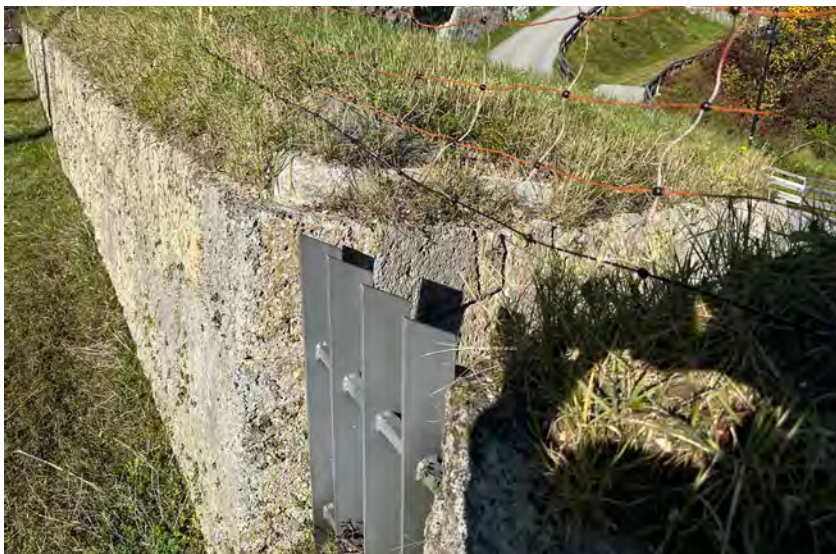
Abdeckung in gutem Zustand.
