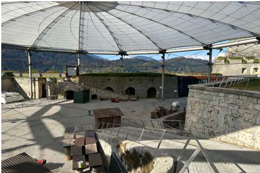
Blick in den Hof mit den Rampen auf die Kasemattendächer.
