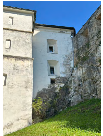
Abgeplatzte Putzoberfläche.
