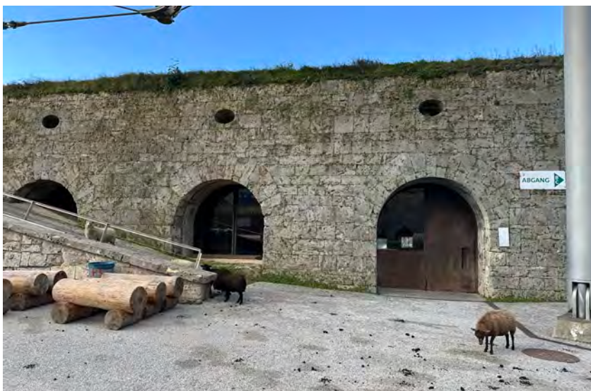
Rundbogenöffnungen zum Hof mit Metalltüren und Fenstern in Metallrahmen verschlossen.
