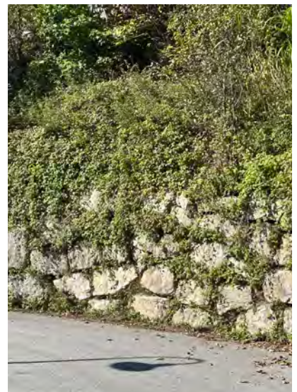
Stützmauer aus Bruchsteinen.
