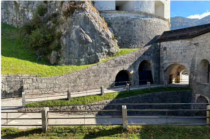
Begleitmauern im Hofbereich.
