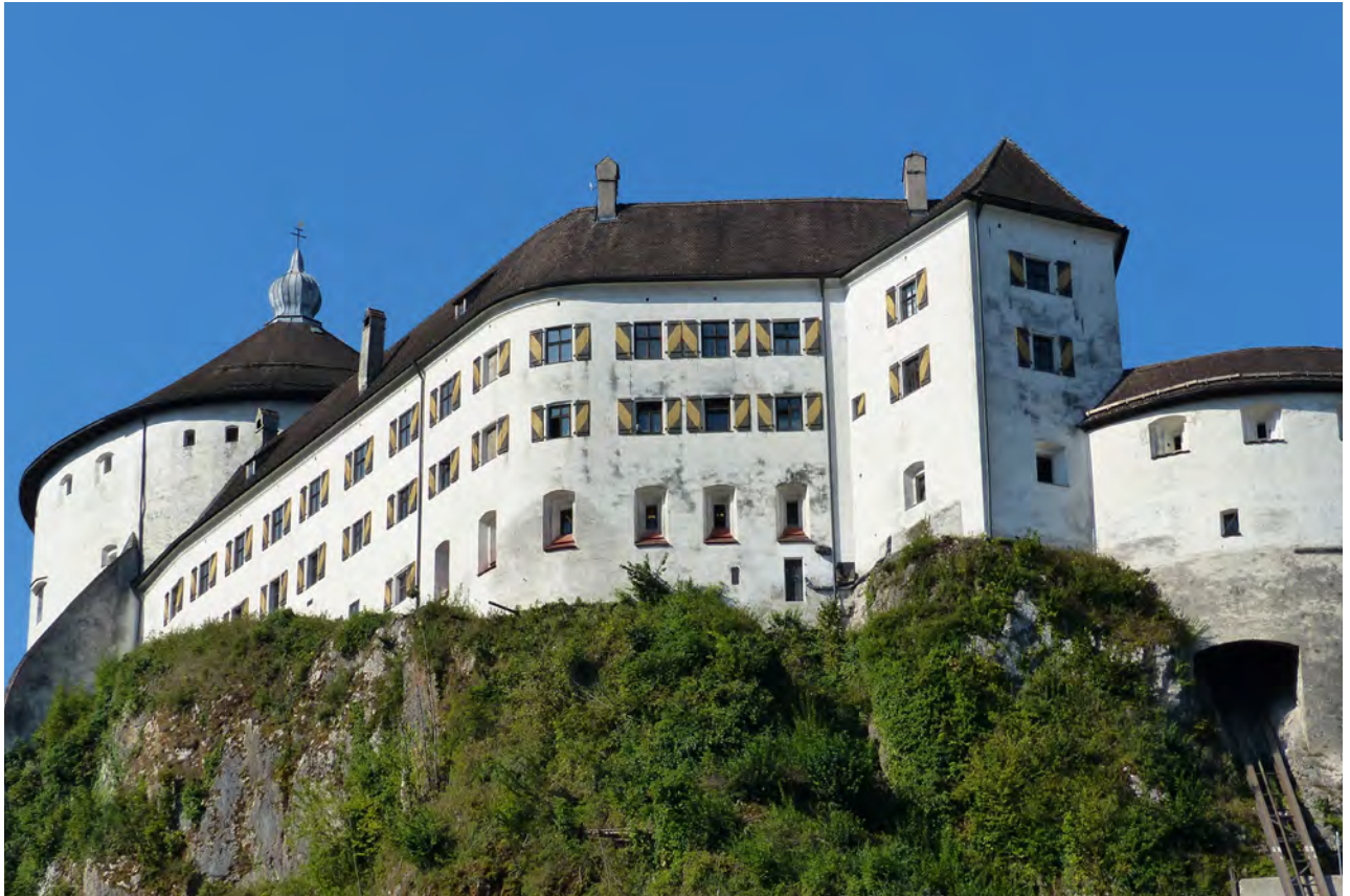
Aufnahme Richtung Südwesten mit Blick auf Nord- und Ostflügel.
