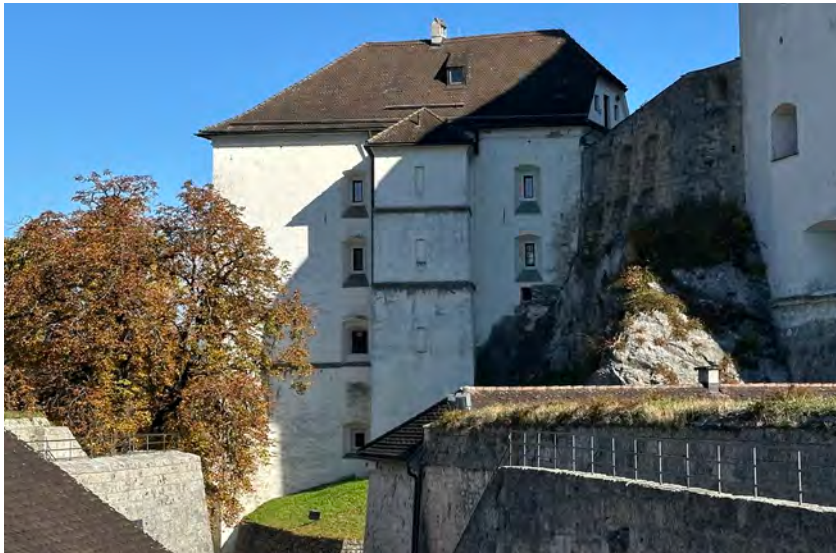
Aufnahme Richtung Norden mit Blick auf die Schmalseite des Westflügels, Stützmauer.
