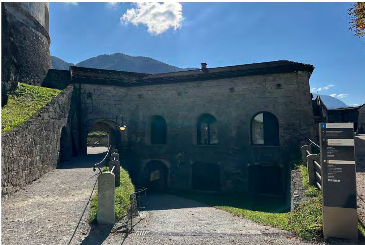
Aufnahme Richtung Südosten mit Blick auf das Artillerie-Laboratorium, links Durchgang zur Elisabeth-Batterie.
