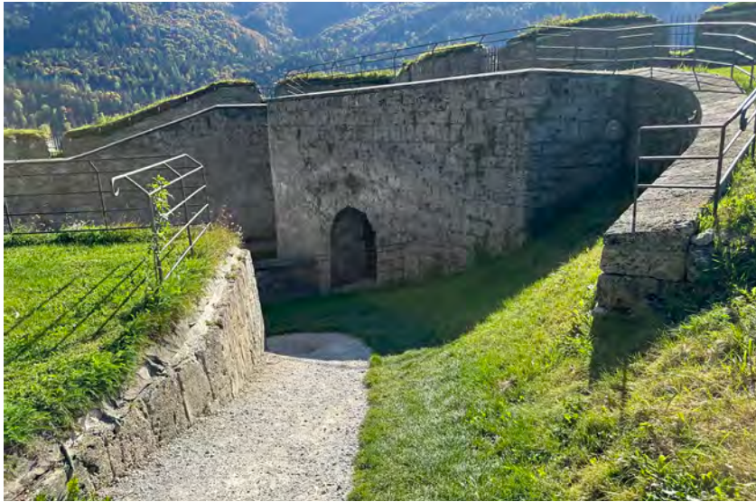
Innenbereich des Pfauenschweifs, begrünte Wehrgangebene, Begleitmauern.
