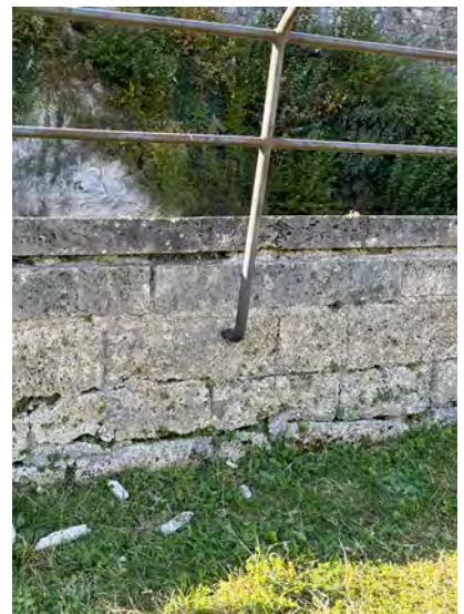
Brüstungsmauern mit Tuffsteinplatten.
