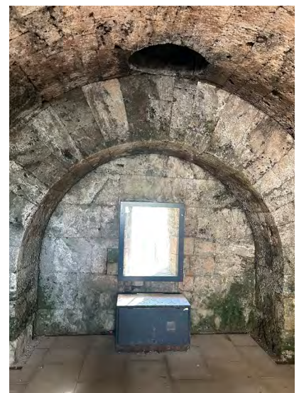
Fenster und Elektrokasten.
