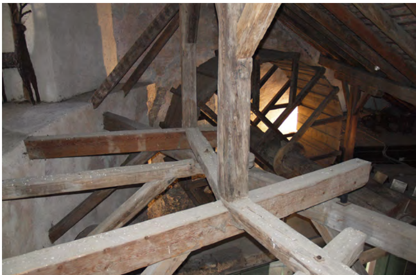
Dachkonstruktion im Aufzugsgebäude, hölzernes Aufzugsrad.
