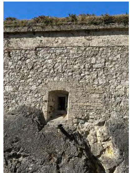
Bruch- und Tufsteinmauerwerk.
