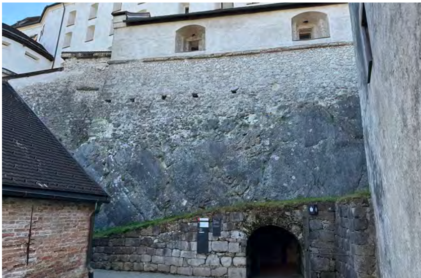
Schmiedegebäude, darunter Eingang zum Felsengang.
