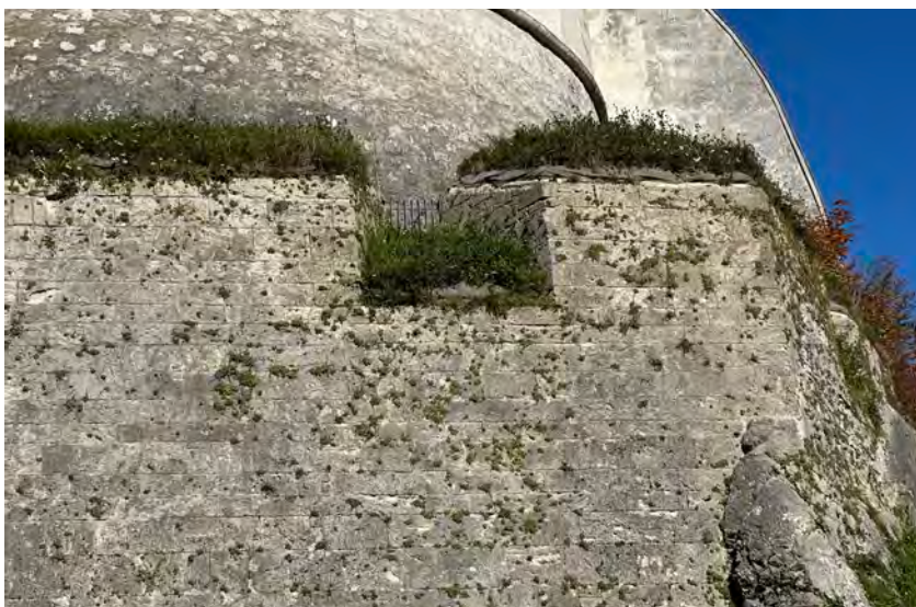
Kronenabdeckung schadhaft, leichter Kleinbewuchs.
