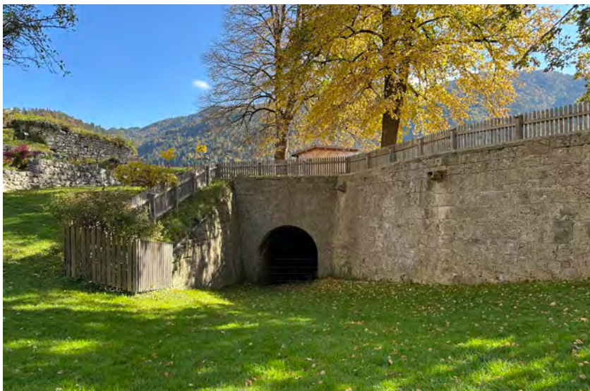
Anna-Batterie, mit Blick auf den ehemaligen Durchgang zum Eugen-Halbhornwerk.
