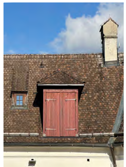
Gauben in den Dachflächen.
