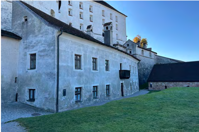
Mannschaftsgebäude, im Hintergrund oben das Schmiedegebäude.
