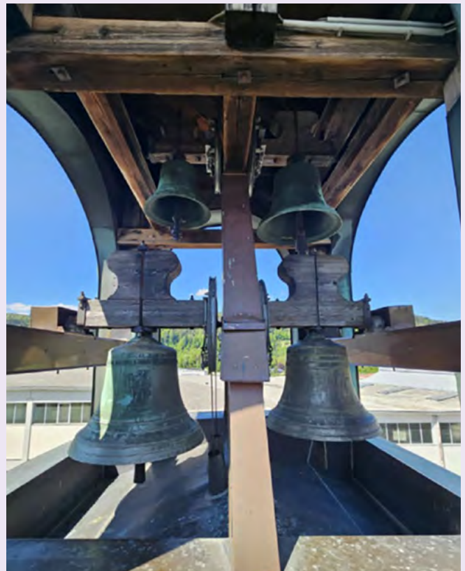
Blick in den Glockenturm: Verwitterte Fassaden und knapp schwingende Klöppel verdeutlichen den Sanierungsbedarf.
