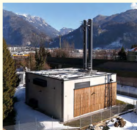
Die Stadtwerke Kufstein bauen das Fernwärmenetz kontinuierlich aus.
