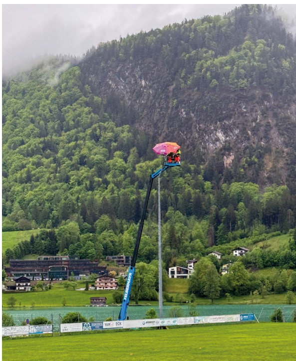
Spezialaufträge erfordern außergewöhnliche Maßnahmen, so auch beim Tausch der Strahler der Flutlichtanlage Thiersee.
