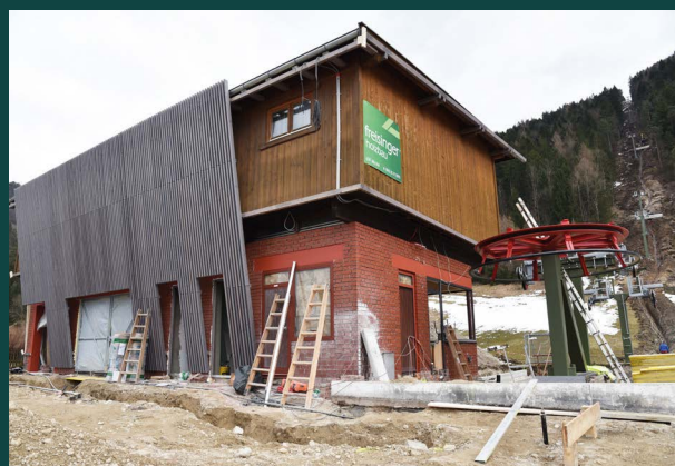
Die Stadtwerke Kufstein übernahmen den Kaiserlift im Jahr 2014 und investierten in eine umfassende Sanierung. Am 1. Mai 2015 nahm der modernisierte Lift seinen Betrieb wieder auf.
